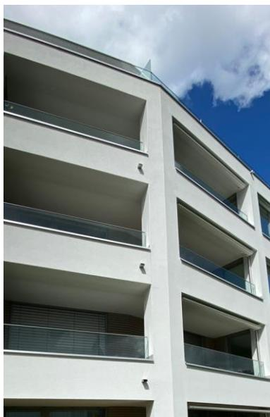
Bild 5: Beispiel: Außenansicht mit verputzter, mittlerer Betonstütze
