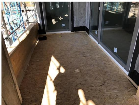
Bild 3: Rohbau mit Balkon aus Holzkonstruktion [Quelle: stonecorner.ch]
